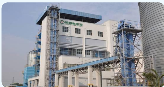
» 红塔仁恒生物质锅炉
